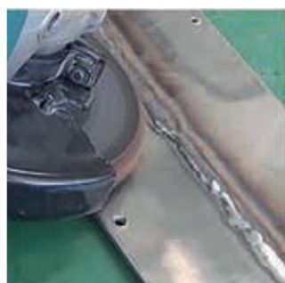
Limpeza em cordões de soldadura
